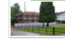
Edificio del siglo XVII del Living Lab (en restauración)
