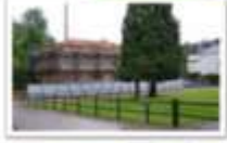
EL EDIFICIO DEL SIGLO XVII DEL L'ÉVINC LAB (EN RESTAURACIÓN)
